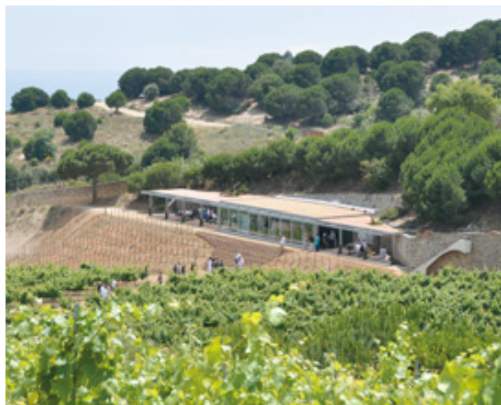
El nou centre, exemple d'integració en el paisatge.
