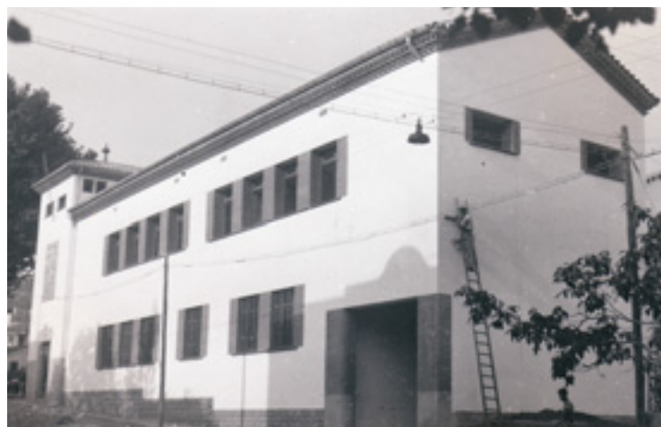
Vista general de l'edifici des de la carretera, un cop finalitzades les obres.
