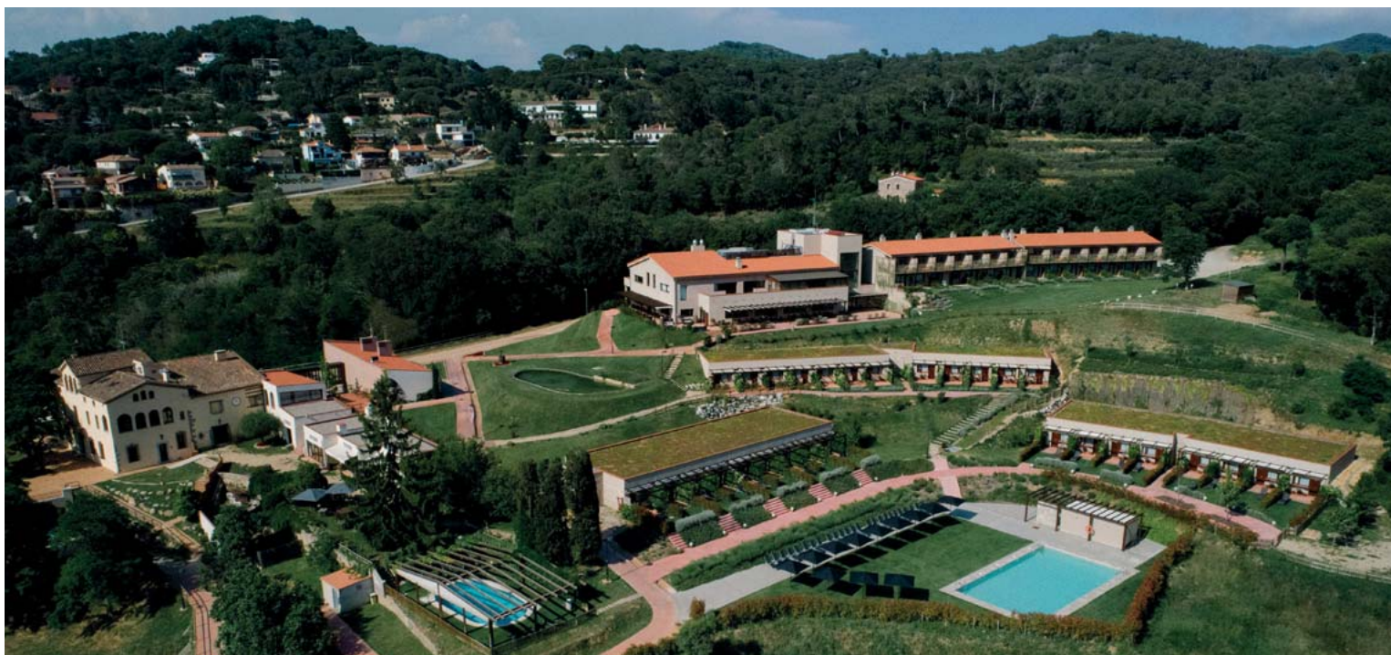
Vista aèria de les instal·lacions acabades de renovar del Mas Salagros.
