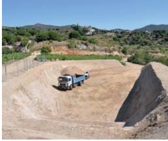
Obres del Celler de les Aus, excavat al sauló.
